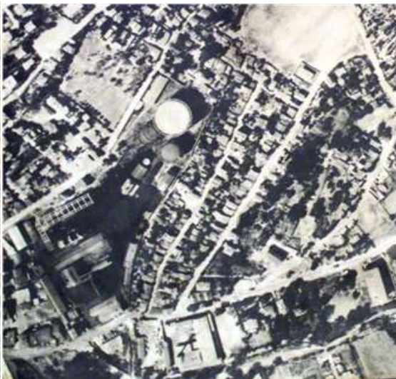
Şekil 2. Hasanpaşa Gazhanesi hava fotoğrafı 1966 (YTÜ, 2008)
